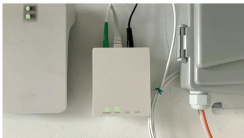
Abb. 6: Blick in den Technikraum mit einem HAK, einem ONT und einem Modem
