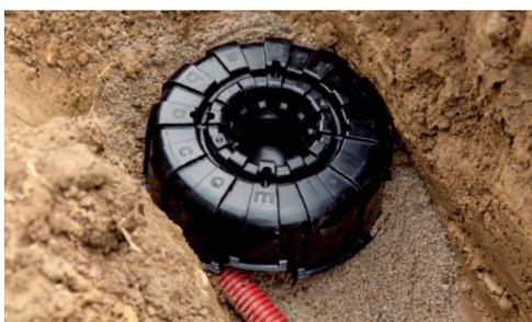
Abb. 2: Abdeckung über der vergrabenen Leerverrohrung
