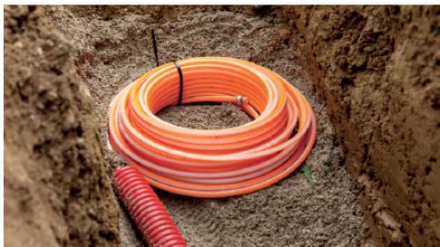
Abb. 1: aufgerollter Bund Glasfaser-Mikrorohr
